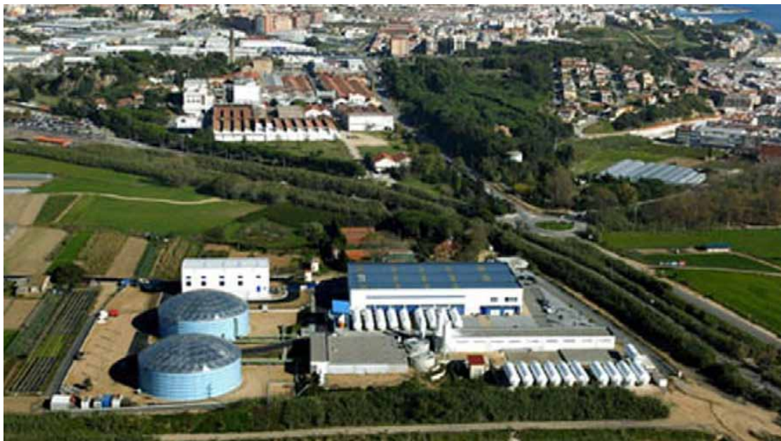
Desalinizadora de la Tordera, en Blanes. / ACA
