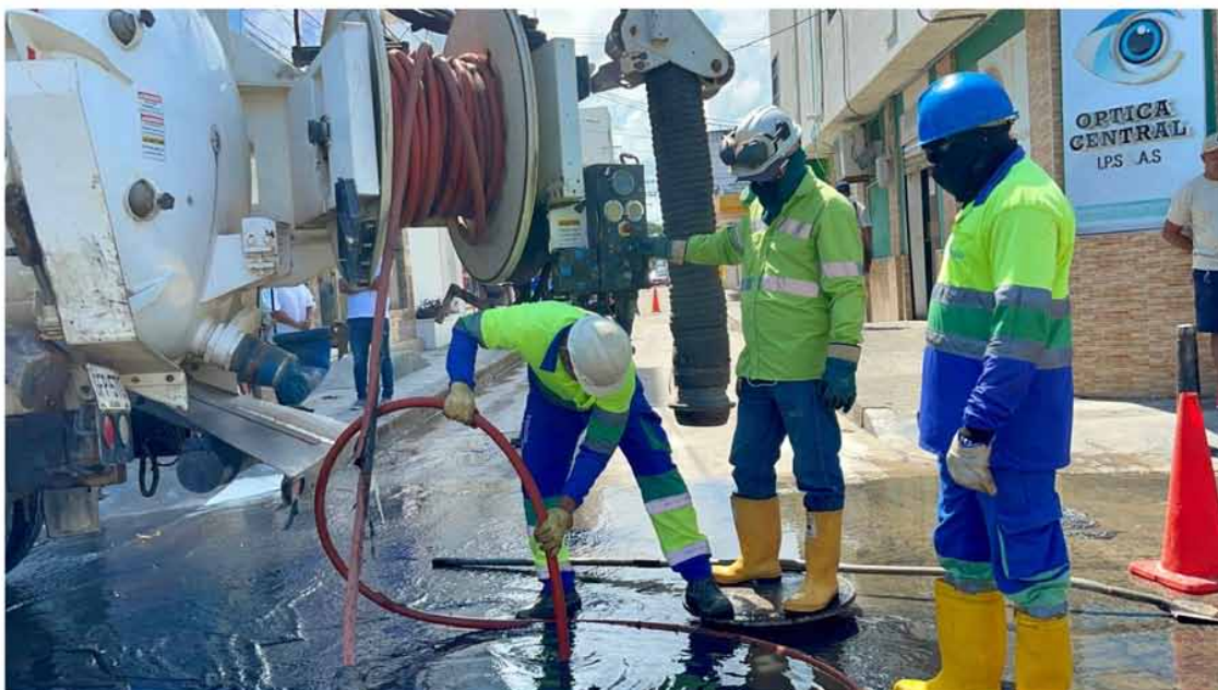
Aspectos de los trabajos de mantenimientos que realizaron los operarios de Aqualia por diferentes sectores de la ciudad de Riohacha.
