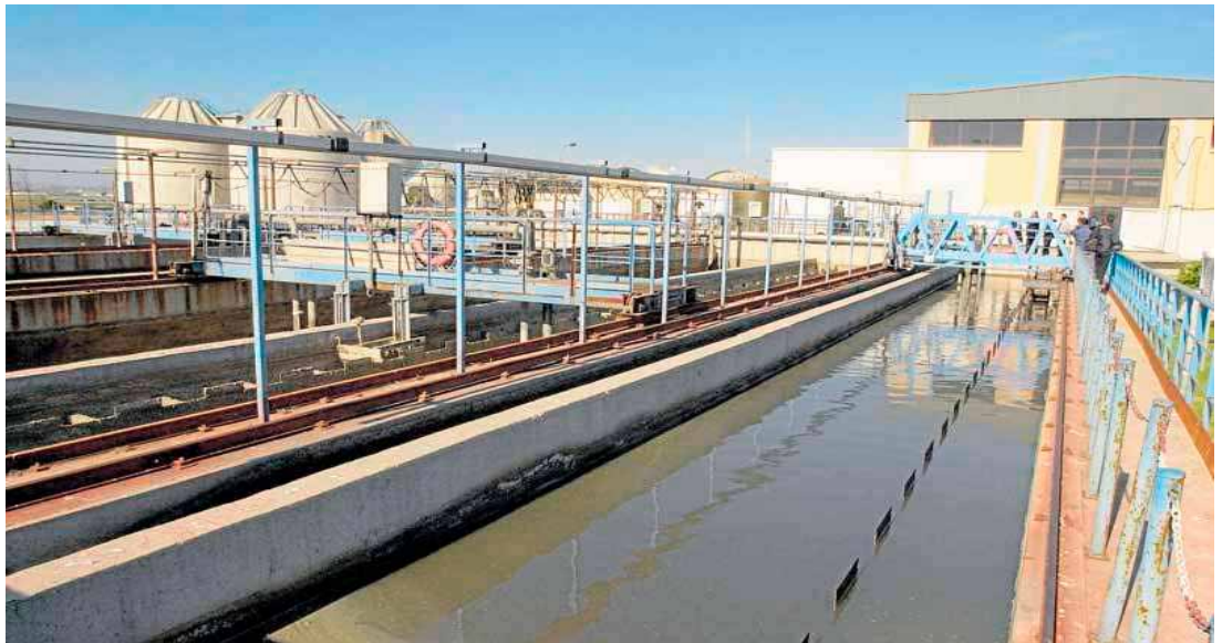
Imagen de archivo de la depuradora del Guadalhorce. SUR
