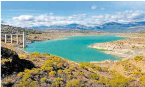
El embalse de la Viñuela, en la provincia de Málaga, ayer al 13% de su capacidad. ÁLVARO CABRERA (EFE)
