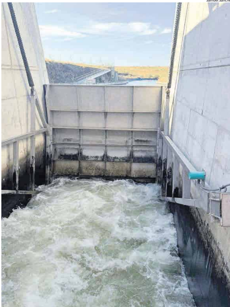
Infraestructura de riego del Canal de Orellana próxima a la localidad de Acedera.
